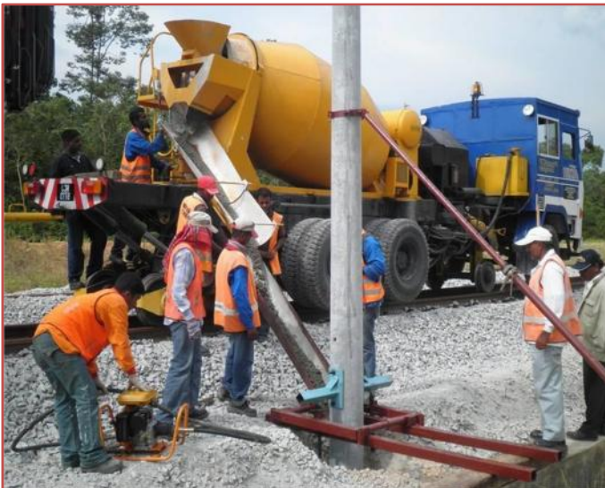
OCS Pole Concreting
